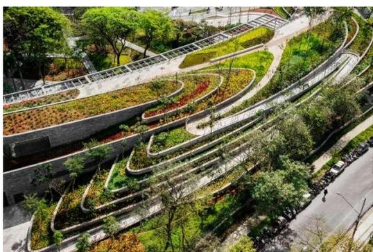
O Projeto tem como gestão principal a água. Como funciona? A Balmori Associates trabalhou com a melhor metodologia para evitar a perda de água, onde um caminho elevado é fornecido com uma grade de metal com furos. Além disso, a água da chuva é coletada e usada para resfriar os edifícios e depois usada como irrigação para a floresta. Finalmente, a água das fontes é usada para lavar os banheiros.
