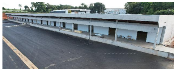
Área de depósito de produtos foi entregue em março/24
